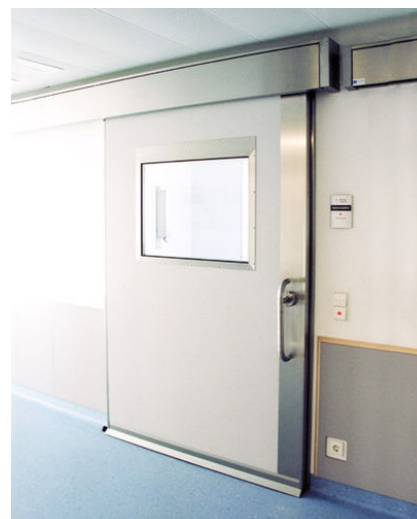
FIGURE 3 – Porte coulissante à commande déportée
